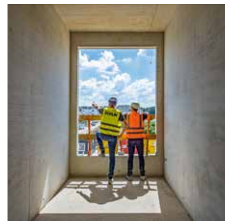
Fast 100 Prozent der Oberflächen im neuen Gebäudekomplex bestehen aus Sichtbeton. Außergewöhnlich daran: Der Sichtbeton bildet keine glatte Oberfläche. Er ist durch eine dezente Maserung – Holz nachempfunden – gekennzeichnet.
