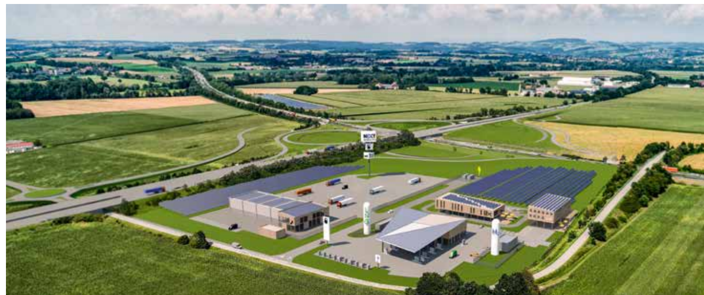
Am künftigen Autobahndreieck bei Pocking planen MaierKorduletsch und Paul Nutzfahrzeuge zusammen mit dem Shell-Konzern den „Mobilitätshub“.
